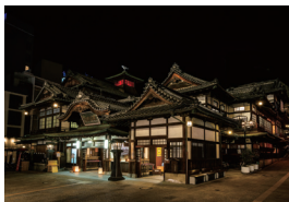
※道後温泉本館(保存修理工事前)
